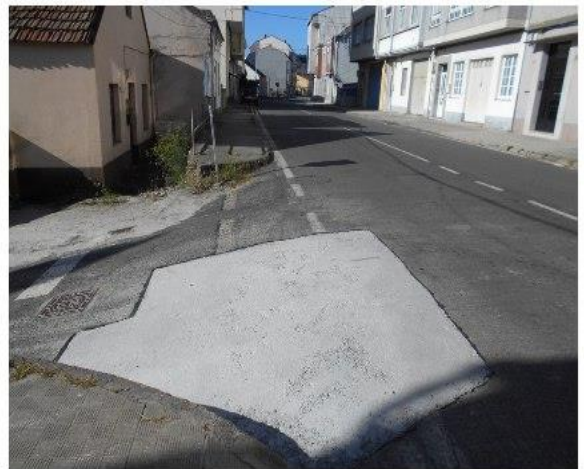
Reparación de canalización de fibrocemento (Fonte: EMAFESA)
